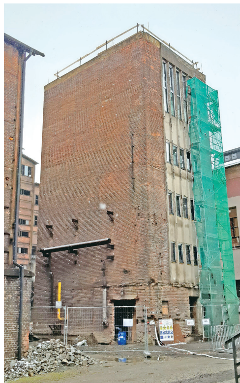
Práce na proměně budovy jsou v plném proudu.
