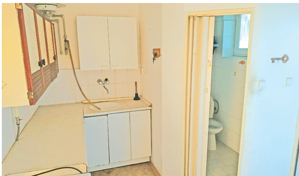
Byty v historickém objektu U Tiskárny 2 čekají na rekonstrukci a své nové nájemníky.
