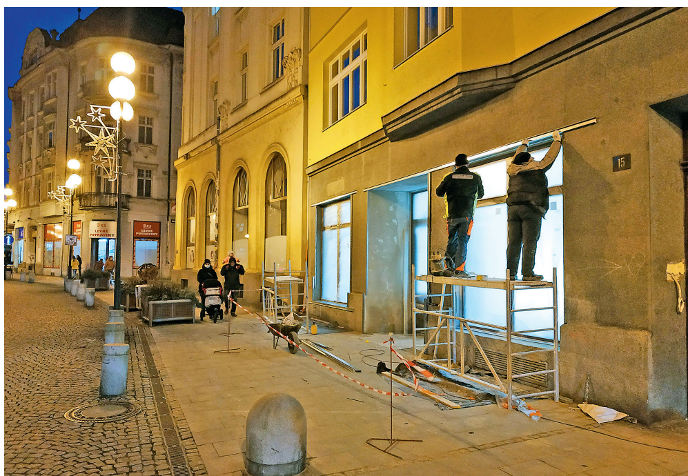
Dům v ulici Poštovní byl nedávno opraven, vznikly zde dva nové nebytové prostory.
